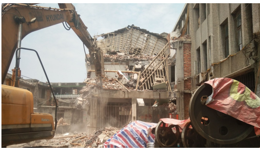
韩田拆违现场
