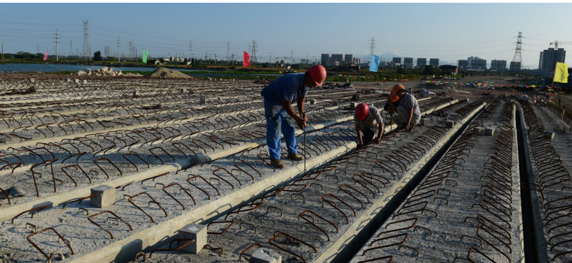
凤锦路施工现场
