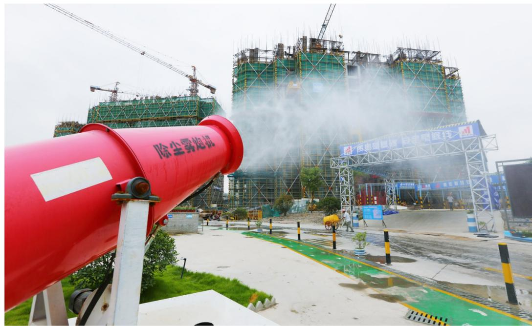
近日,在新湖广场建设工地上,除尘雾炮机启动工作,将水以雾状喷出,与粉尘凝结后降落,有效压住地面粉尘,起到降尘效果。
