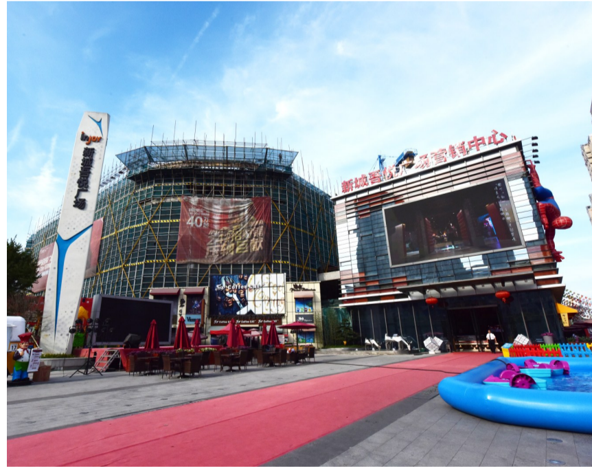
建设中的吾悦广场
