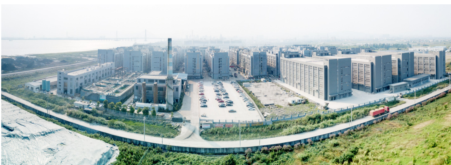
电镀园区航拍图
