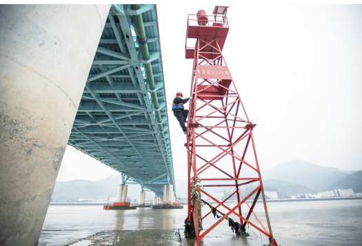
在五桥桥墩上作业
