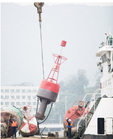
安装新航标·起吊
