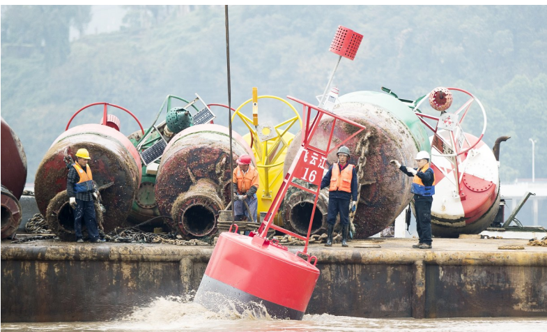
安装新航标·下水
