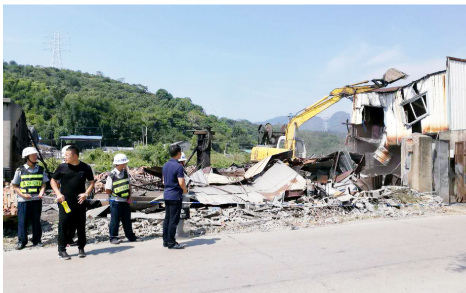
桐浦镇拆除违章建筑
