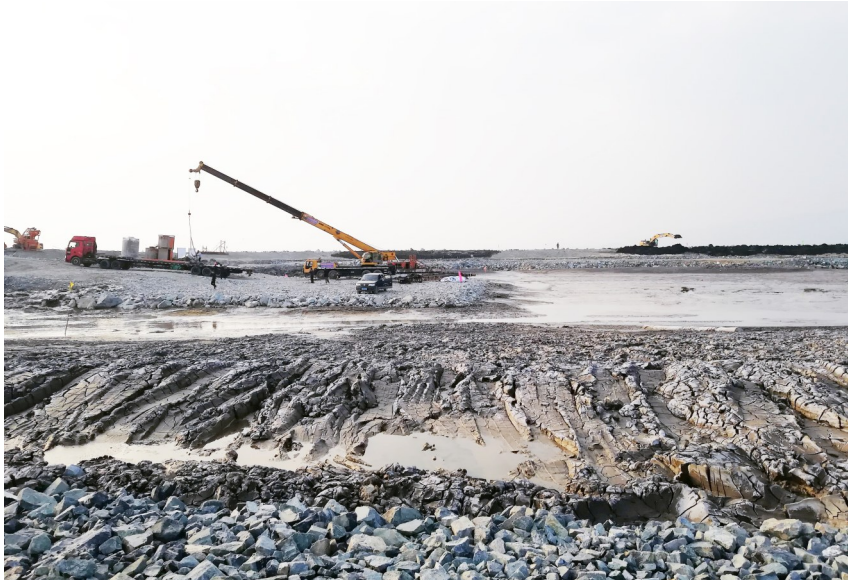
丁山三期西片北区1阶段施工现场
