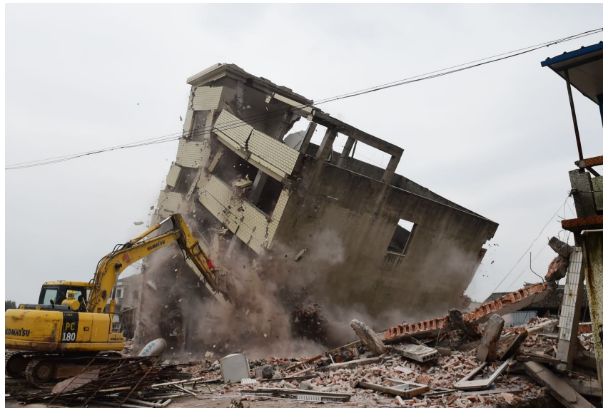
拆除一期旧房
