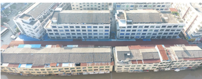
陶山镇万兴商场违法建筑拆除前
