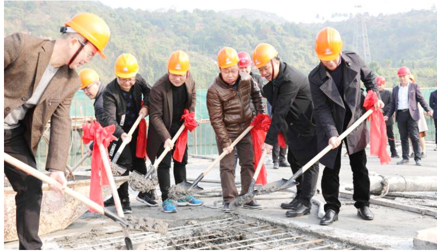
医院领导班子完成二期工程顶层最后一方混凝土浇筑
