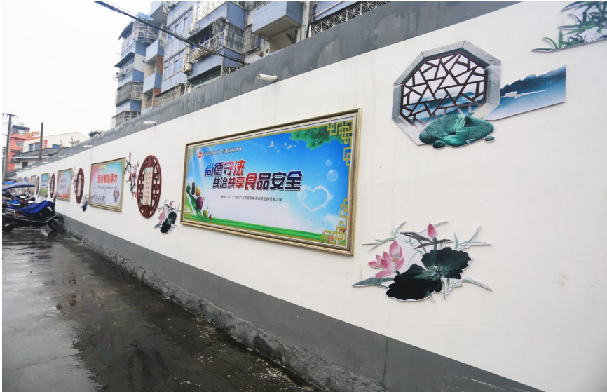
墙体立面整改
