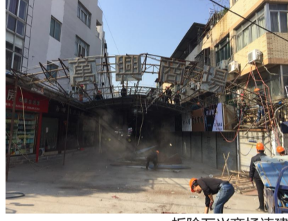
拆除万兴商场违建
