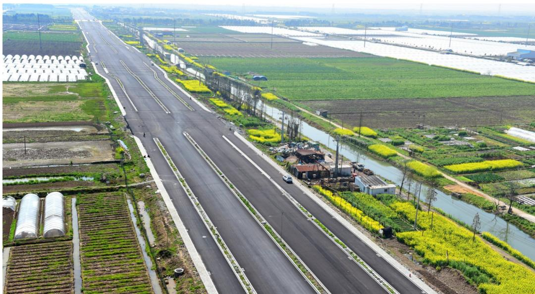
塘下镇中心路延伸工程一期(滨海大道至凤锦路)已完成沥青路面铺设,近日已进入道路绿化和路灯的设计阶段。据悉,塘下镇中心路延伸工程全线建设分三期实施,一期工程长约2.4公里,道路标准路幅宽42米,双向6车道,设计车速每小时50公里,项目投资近2亿元,预计2018年底可通车。(记者 陈立波)
