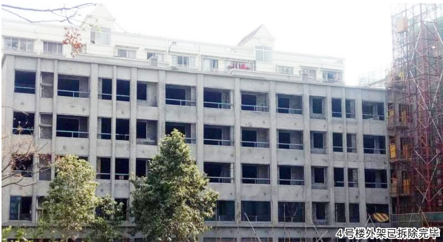
4号楼外架已拆除完毕
