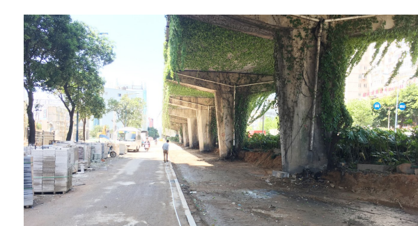
东侧绿化带已经拆除
