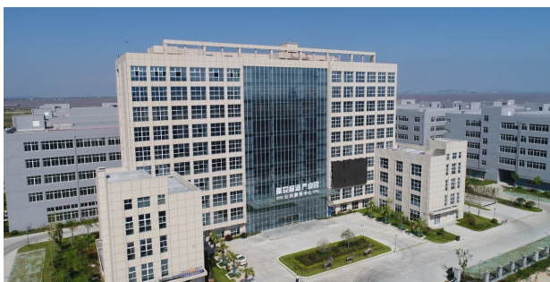
瑞安智造科技服务中心大楼
