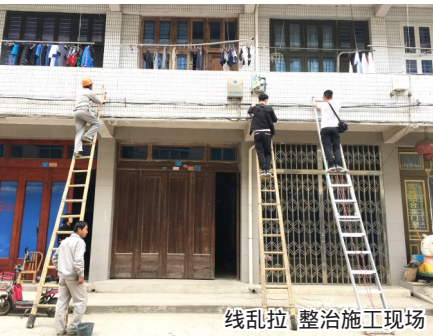
线乱拉 整治施工现场
