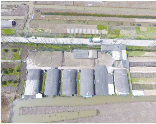
养鸡场拆除前
