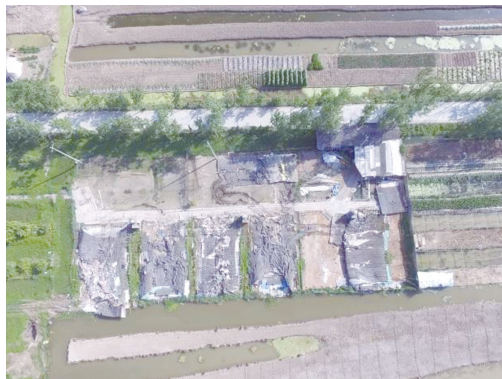
养鸡场拆除后
