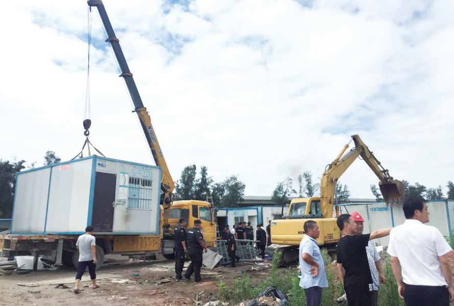
梅头园飞地内60多间移动板房被拆除
