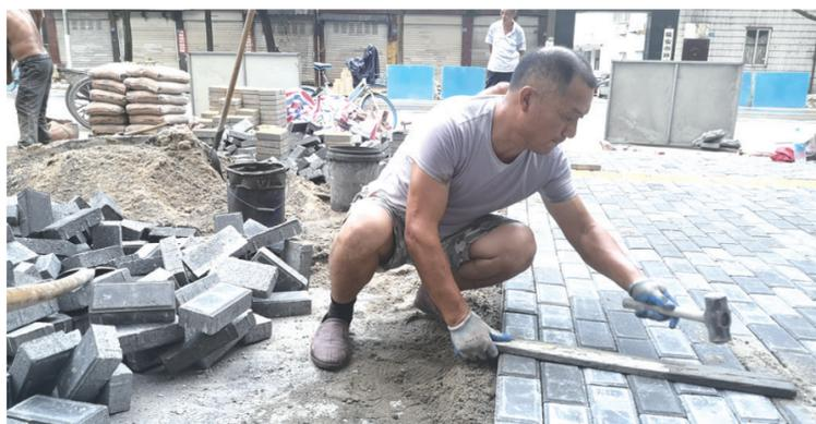
先老旧破损的彩砖换成透水砖,混凝土侧石换成花岗岩侧石等。
