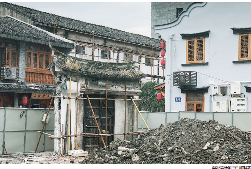
鲍宅施工现场
