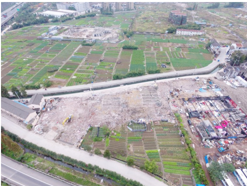
外厂滨水绿地房屋拆除后
