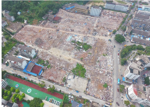
周岙房屋拆除后
