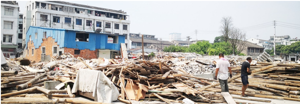
周岙村城中村改造项目房屋拆除现场
