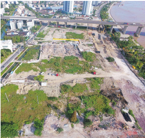
滨江三期拆除后
