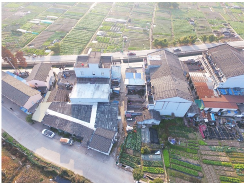
外厂滨水绿地房屋拆除前
