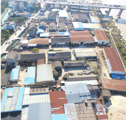
滨江三期拆除前
