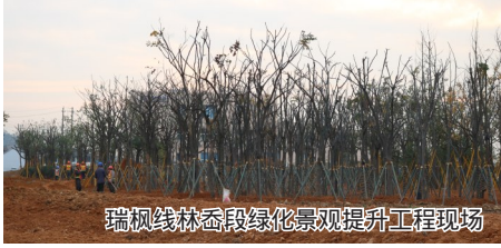
瑞枫线林岙段绿化景观提升工程现场
