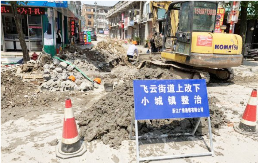
飞云街道电线“上改下”工程施工现场
