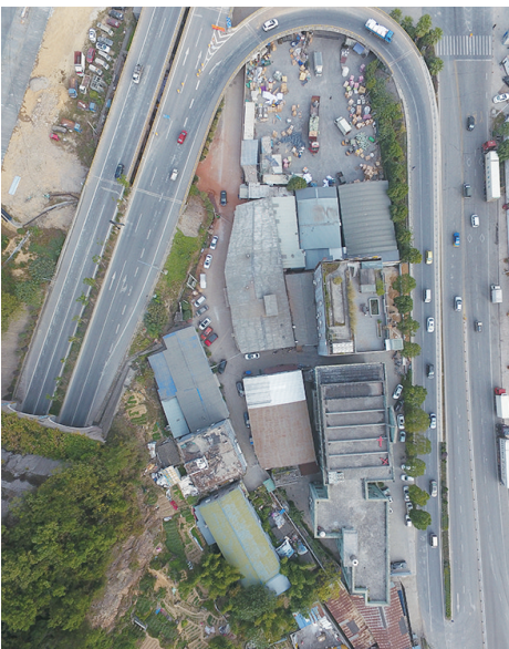
牛伏岭互通违建地块(整治前)
