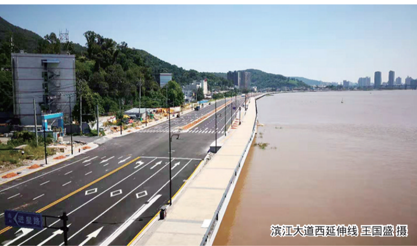
滨江三期施工现场
