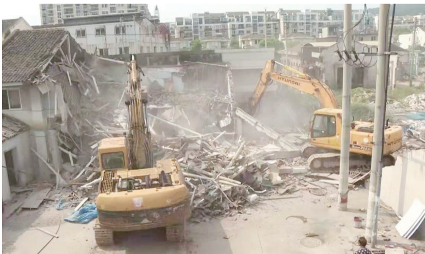
塘下邵宅工业区团块拆改现场
