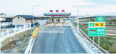
甬台温高速公路复线瑞安东互通
