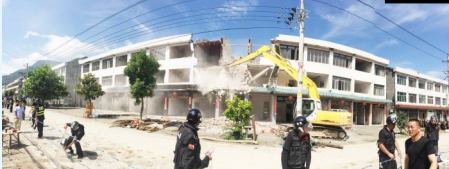
龙丽温高速公路瑞安段施工现场
