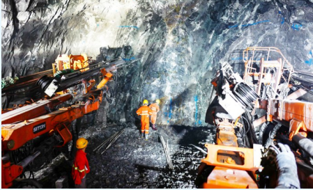
龙丽温高速公路隧道内多臂凿岩机在施工
