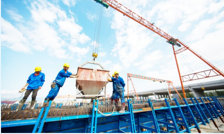
龙丽温高速公路工人在预制梁板
