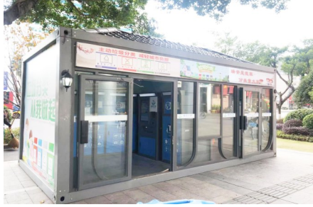
万松东路与安阳路十字路口处,人行道旁的垃圾分类智能屋。
