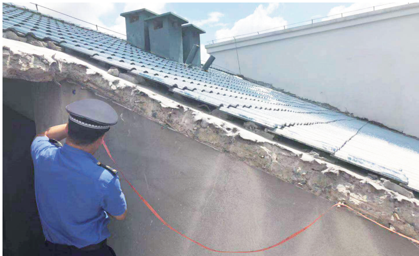
执法人员在房屋装修现场测量拆除面积
