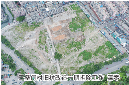
三圣门村旧村改造一期拆除工作“清零”
