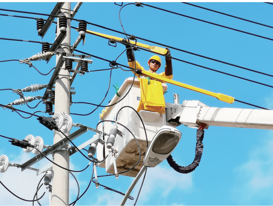
带电作业班在塘下镇110千伏海阳线开展无负荷带电搭接引线作业
