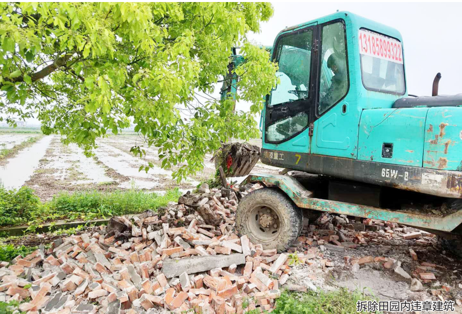
拆除田园内违章建筑
