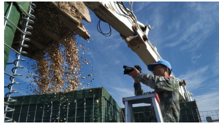
2019年12月11日，薛镭在加纳营区拍摄记录维和分队观察哨施工任务进展情况（陈学山/摄）
