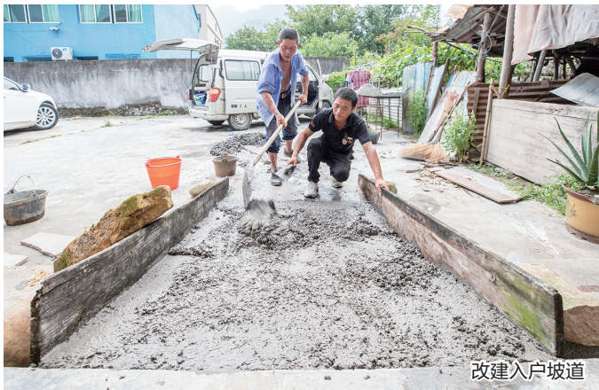
改建入户坡道
