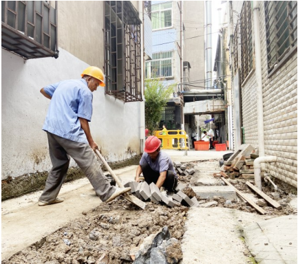
马屿镇 施工人员做雨污分流改造的路面整理
