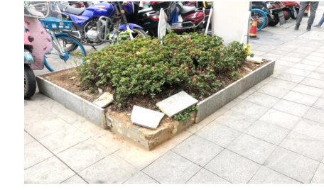
10月22日，万松路市人民医院前，花坛破损。
