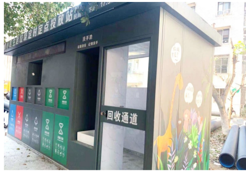
华瑞社区清泰小区老旧小区改造新增的垃圾屋
