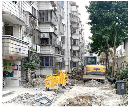
华瑞社区清泰小区老旧小区改造施工现场
