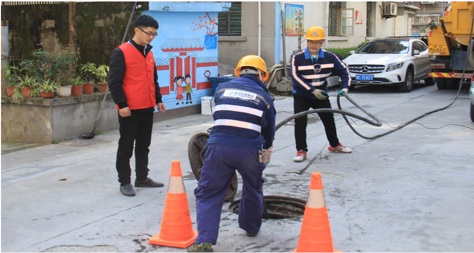
市公用集团志愿者在凤山小区疏通排污管道
