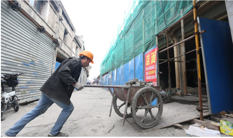
九里汇历史街区改造施工现场
