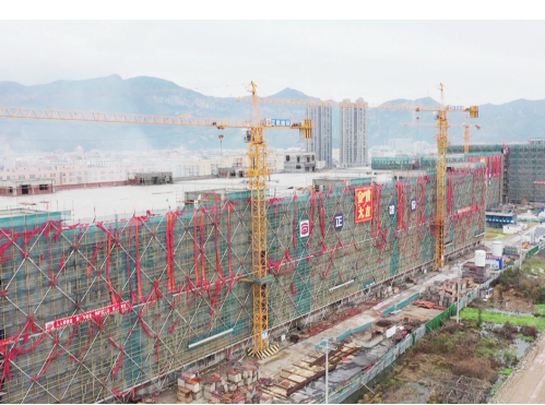
松田智能控制无刷电机生产项目建设现场
