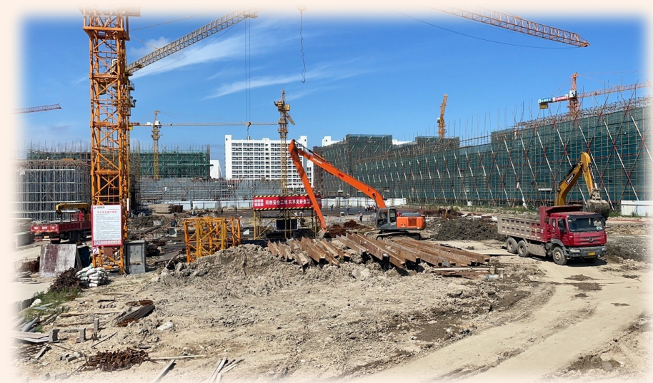
浙江科尔泵业 年产2000台(套)石油化工泵重大装备生产线项目施工现场
