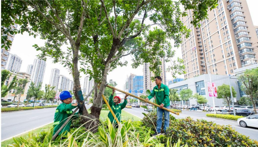
昨日,在万松东路上,园林工人正在用钢管对处在风口口的树木进行支撑加固。当天,30多名园林工人对万松路、安阳路、瑞祥大道等主要路段多个公园的树木进行加固和修剪,确保台风“烟花”登陆期间过往路人及车辆安全。
