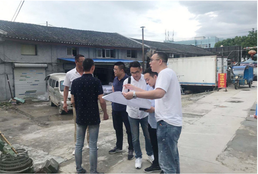
罗建(右二)与攻坚组成员到拆迁一线了解情况
