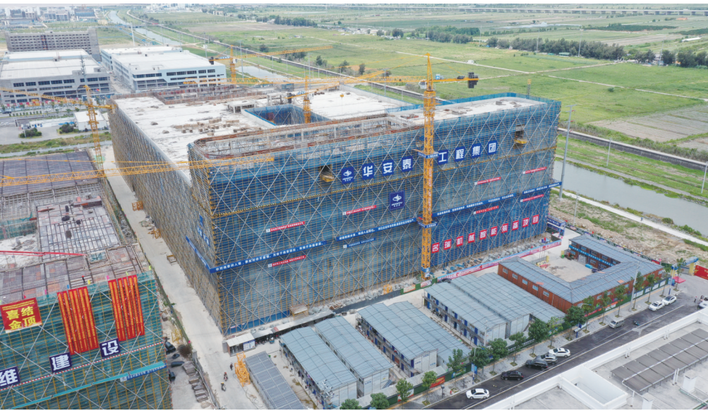
正在建设中的名瑞机械年产2000台智能装备生产线项目
