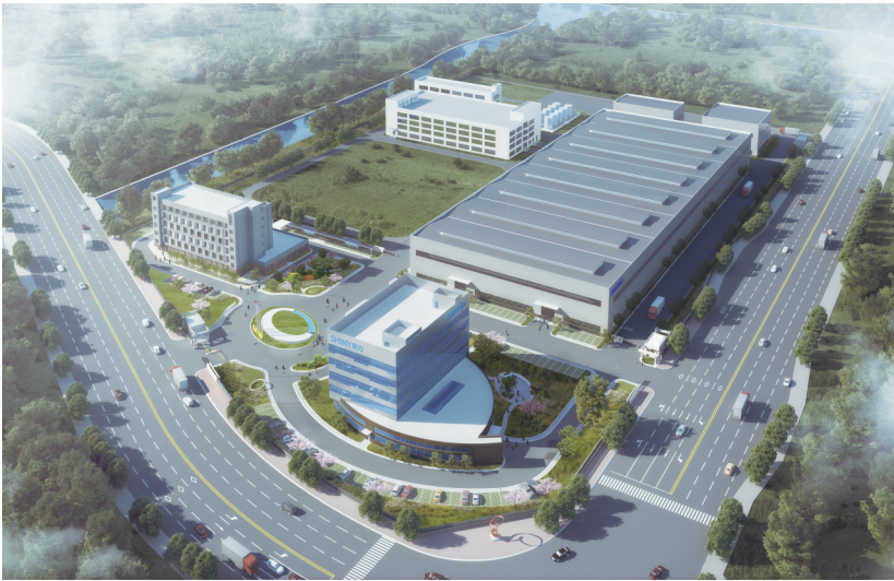
新力新材丁山二期新厂房
