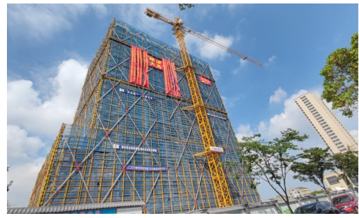
就地地块保障房项目（R-2-1地块）工程顺利结顶
