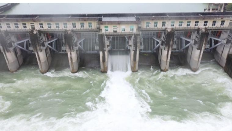
本报讯(记者 张森 董伟)前日上午,在赵山渡水库,第13号闸门开度1米,以每秒136立方米的流量进行泄洪。近期连续降雨导致我市主要水库水位上涨,赵山渡水库水位最高上涨至21.73米,逼近22米警戒水位。从6月10日开始,该水库开闸放水,截至昨日已累计泄洪3989万立方米,目前水位已降至21.45米。
