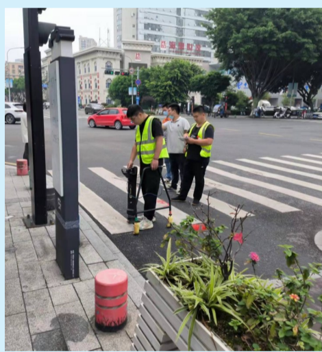
燃气管道检测
