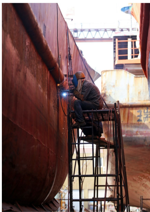
王玉海正在焊接船体
